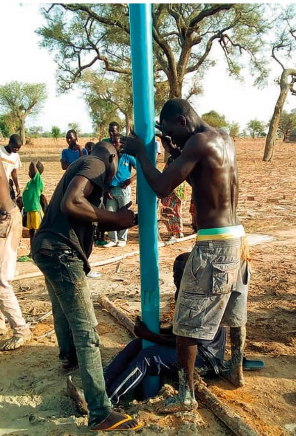
Juni 2020: Einführung des Wasserrohrs zur neuen Brunnenbohrung in Blada / Viri.
