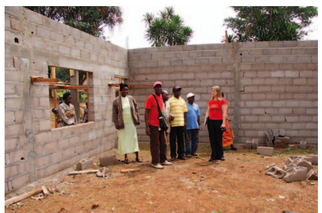
Baustellenbesichtigung Kindergarten PS Tikali
