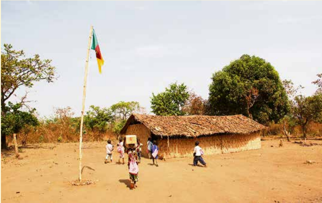
Die Schule von Kongui-Zouem. Im Dezember 2013 konnte Ashia hier den Startschuss für ein neues Schulhaus mit zwei Klassenzimmern geben. Der Bau begann schon am darauf folgenden Tag!
